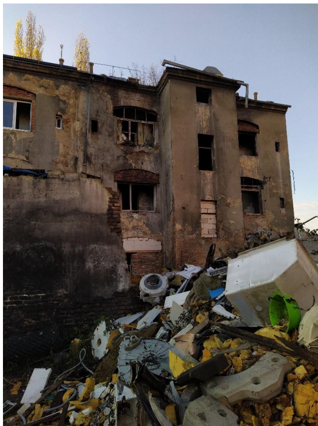
Severní průčelí objektu do dvora, zdivo obvodových stěn je narušené korozivními činiteli a samovolně se rozpadá. Okolí objektu je obklopeno vneseným komunálním odpadem do výšky cca 2500 mm.
